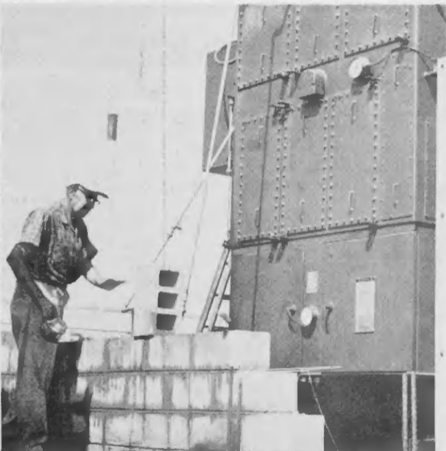
WELDING DI barra di reforzamento ariba un fire wall, ariba robéz, y construccion di e fire wall entre e dos transformernan ta un parti di e proyecto cu lo permiti Lago cumpra corriente for di gobierno.
